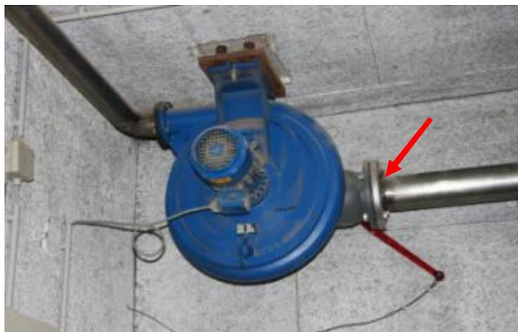
**Abbildung 108:** Biogasleckagestelle an der Flanschverbindung vor und nach dem Gasverdichter (zu wenig Schrauben montiert)
