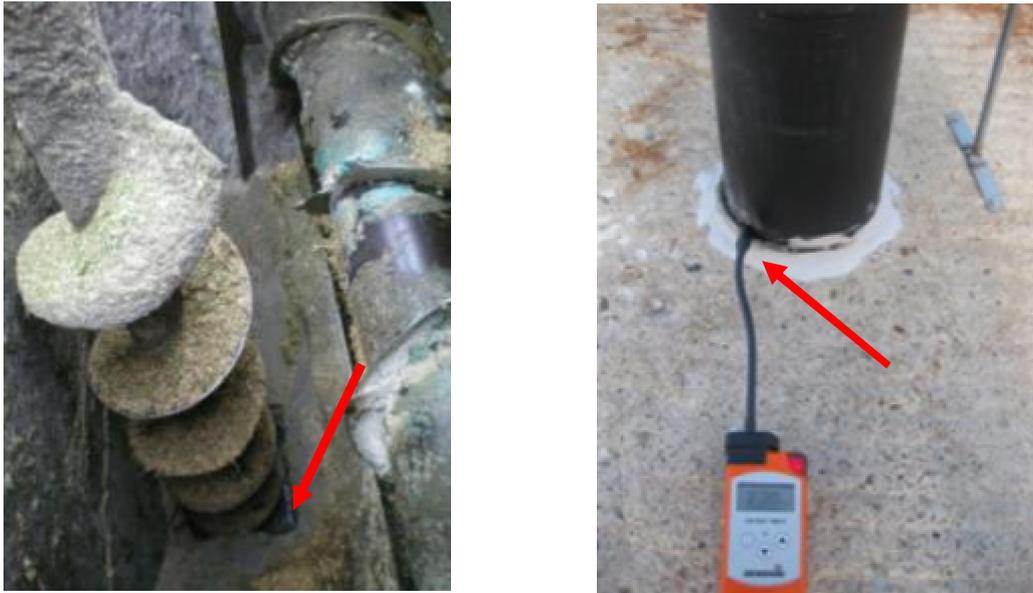
**Abbildung 99:** Eintragsschnecke mit Biogasleckagestelle bei Übergangsstelle Schnecke-Substrat (links) und beschädigte Abdichtung der Fermenterdurchführung (rechts)
