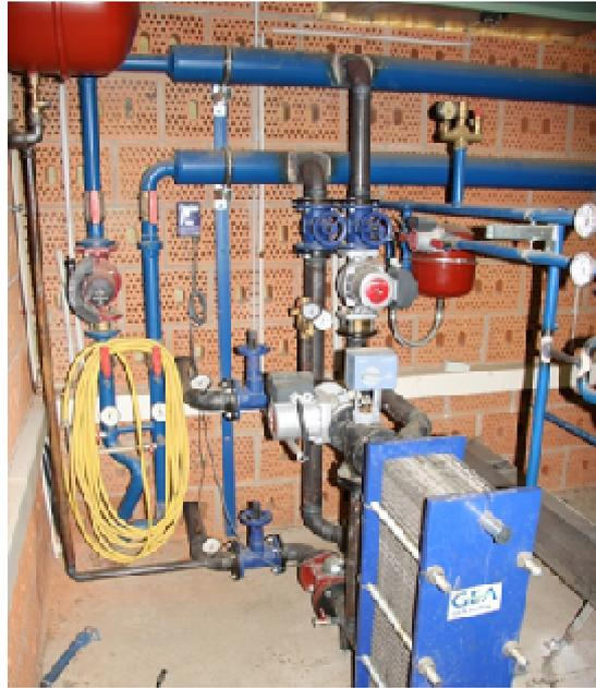
**Abbildung 137:** Wärmetauscher zur Auskopplung der Wärme für Heizzwecke
