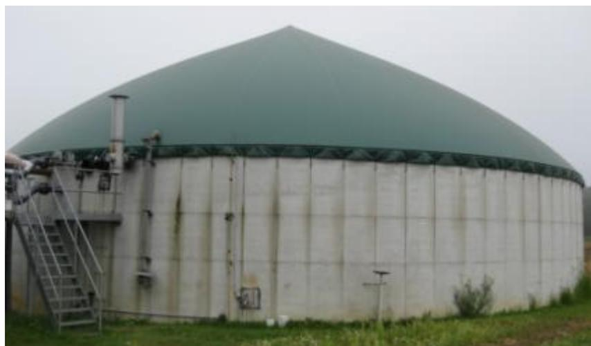
**Abbildung 133:** Gasdichtes Endlager
