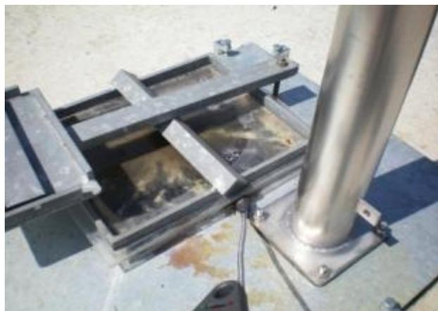
**Abbildung 105:** Biogasleckagestelle an der Notfallöffnung auf einem Betondach
