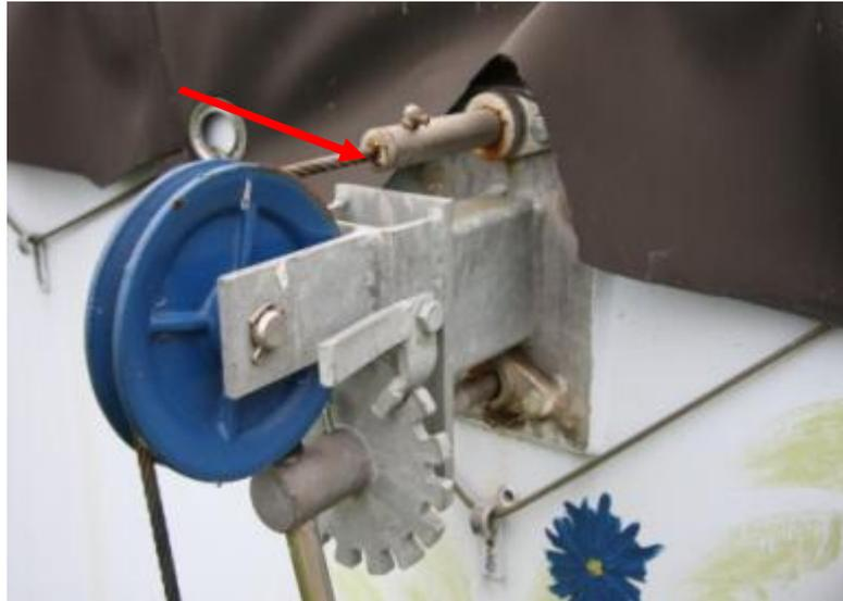
**Abbildung 101:** Biogasleckagestelle Seildurchführung-Tauchmotorrührwerk
