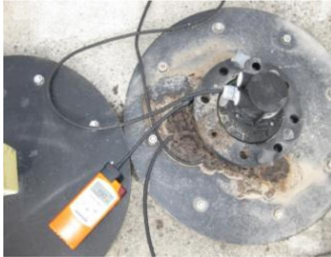
**Abbildung 104:** Biogasleckagestelle an der Redoxpotenzialmessung auf dem Betondach eines Fermenters
