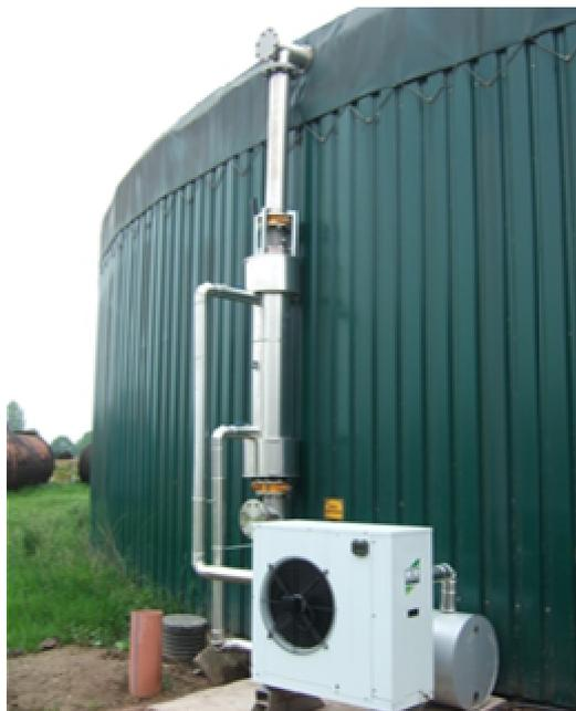
**Abbildung 130:** Gaskühlaggregat an einer 500 kW<sub>el</sub>-Anlage
