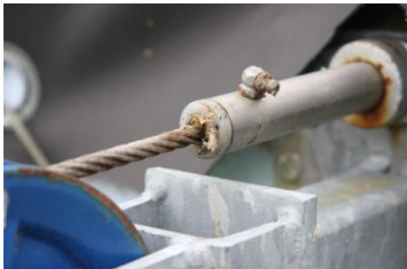
**Abbildung 110:** Methanemissionsquelle an der Höhenverstellung eines Tauchmotorrührwerks von BY7
