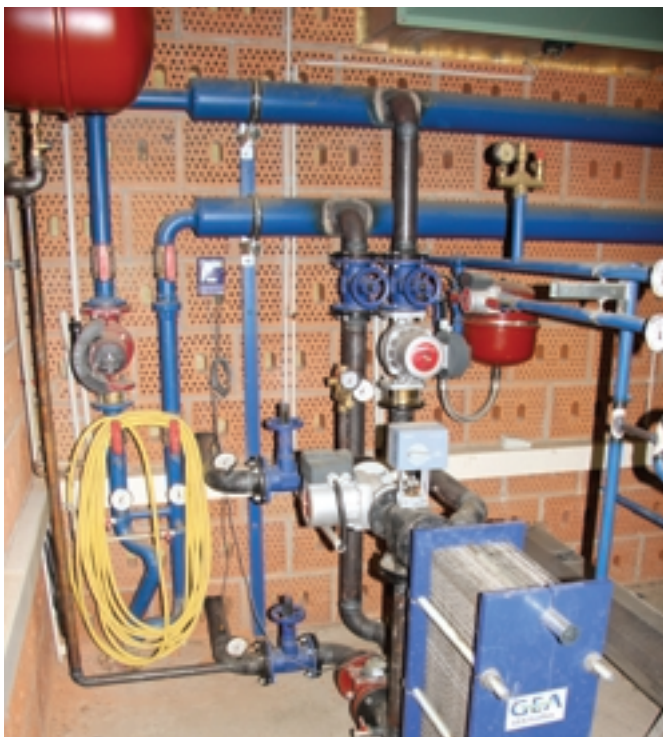
Abbildung 15: Wärmetauscher zur Auskopplung der Wärme für Heizzwecke
